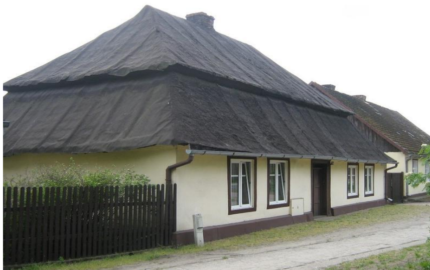
Zdjęcie nr 10. Dom szachulcowy przy ul. Mickiewicza w Trzciel. Źródło: UM Trzciel
